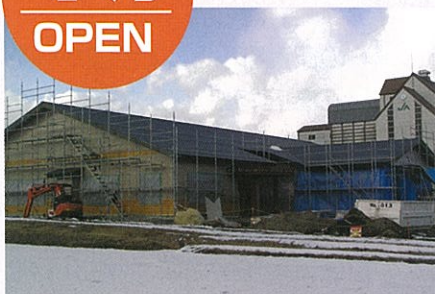
建設が進む虹のホール竜西
